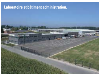
Laboratoire et bâtiment administration.
